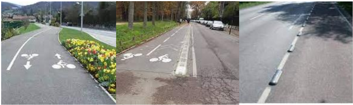
Figure 30. Exemple de séparations physiques.
