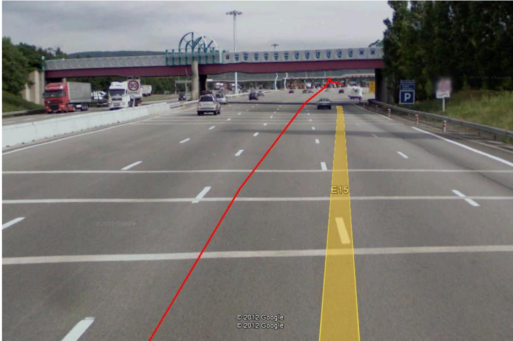
Figure 4 – Exemple d'évènement sur l'autoroute : bandes rugueuses en approche d'un péage
