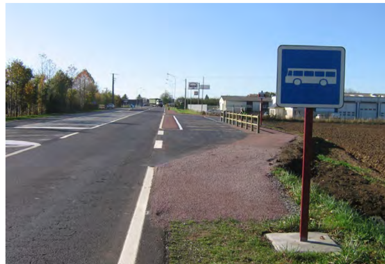
Aménagement d'un arrêt d'autocar sur route départementale
